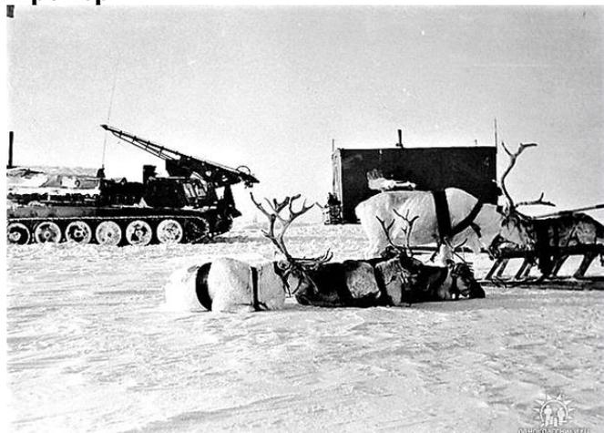
*Буровая установка на базе вездехода, упряжка оленей и на заднем плане балок. Ледовый промер. Фото А.Зыкова.*
